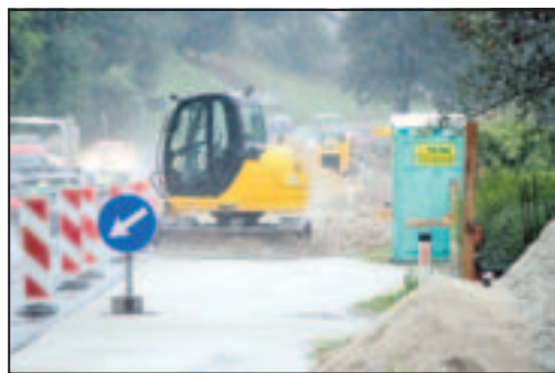
Energetika Ljubljana je konec septembra začela plinovodne cevi polagati ob regionalni cesti na Lukovici.
